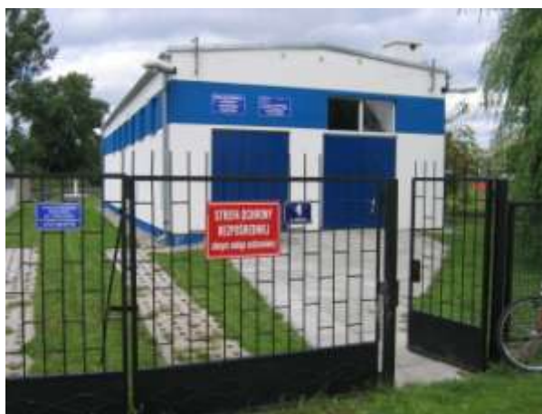
Fot. 6. Stacja uzdatniania wody w Krzycku Wielkim
